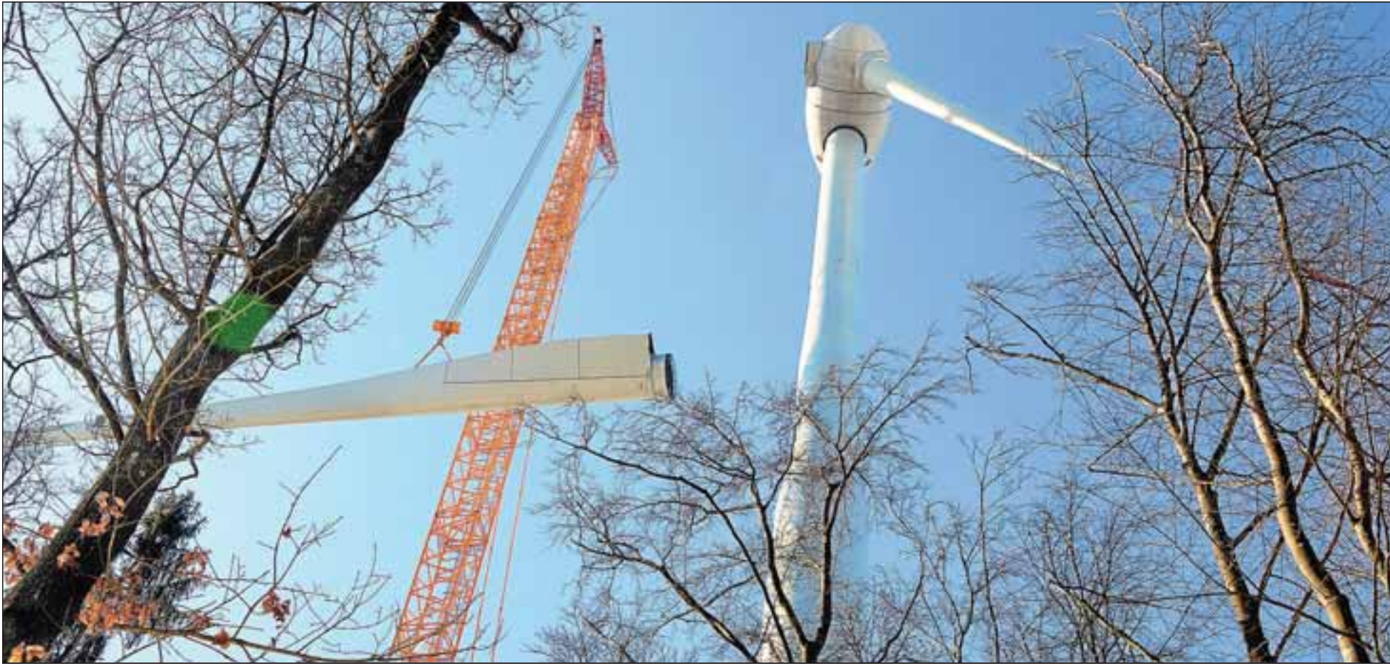
Der Bürgerwindpark Gerichtstetten – unser Foto entstand beim Bau der Anlagen – ist das größte Projekt, an dem sich die Genossenschaft im laufenden Jahr beteiligt. Foto: Rüdiger Busch
