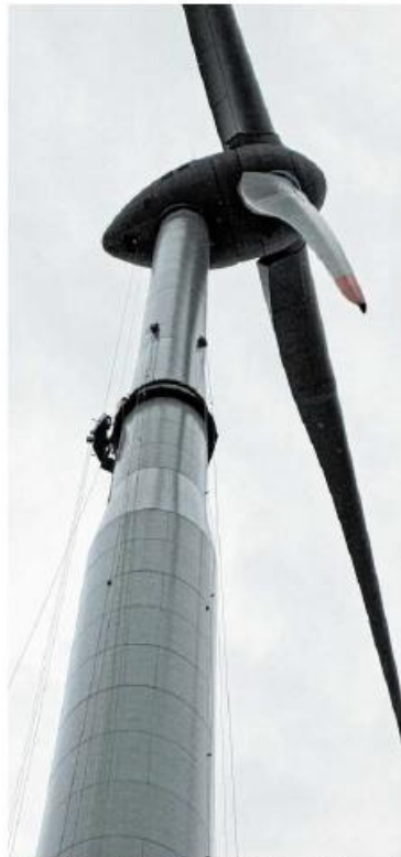
Die Windräder im Bürgerwindpark in Gerichtstetten haben – wie weitere im Bundesgebiet – Risse im Übergangsbereich vom Beton zum Stahl. Die Schäden sollen nun im Rahmen einer Sanierung behoben werden. Die FN trafen sich mit Harald Schmiege (EKS-Solartechnik GmbH) und Bauleiter Andy Riemer von der ausführenden Oldenburger Firma „Windstärke 8 GmbH“ vor Ort.
